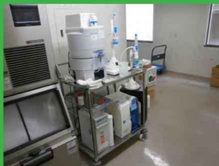
精製水装置（ミリポア濾過方式） (3F 廊下)
